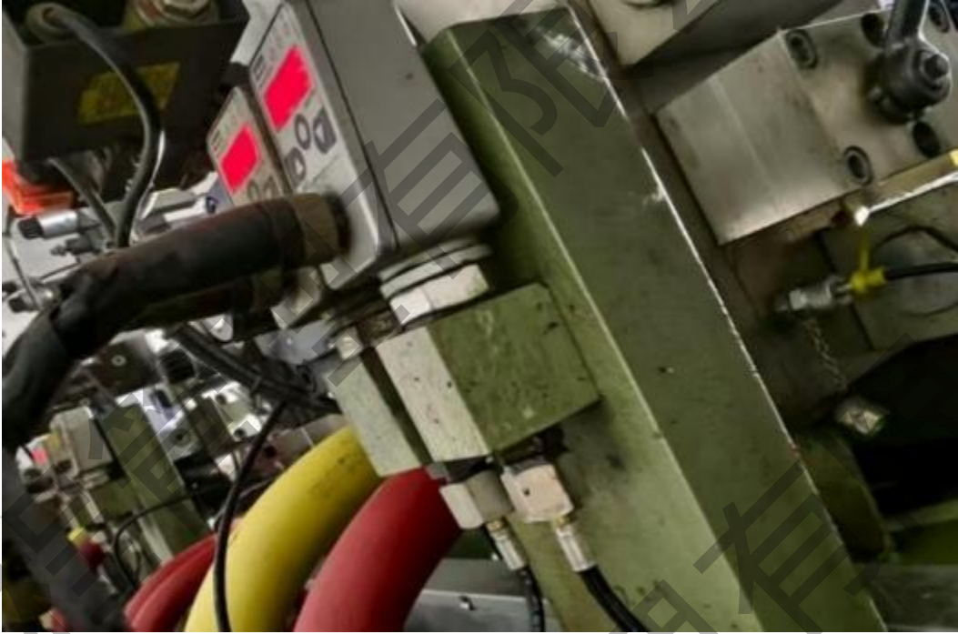
1#泄洪洞工作闸门液压启闭机液压泵站压力传感器渗油
