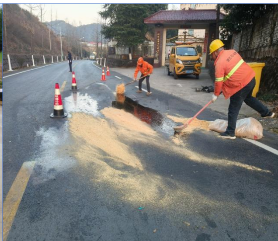
保洁员使用吸附型环保吸污粉处置路面油污作业特写
