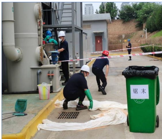
渠东街道突发环境污染事件应急处置现场全景
