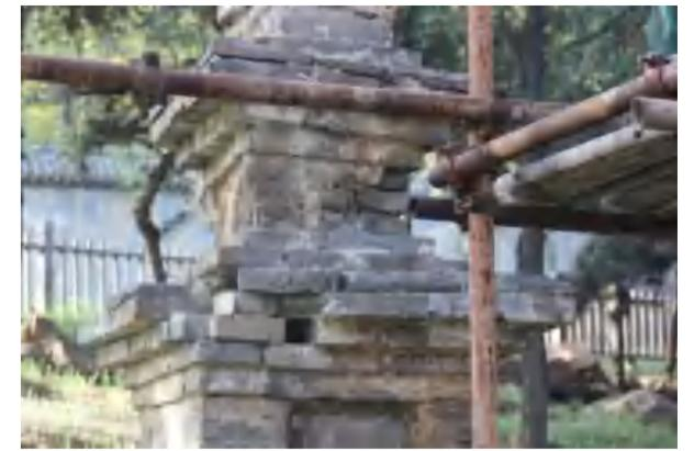
南立面：头层塔檐东侧青砖缺失；二层塔身砌浆流失严重。
