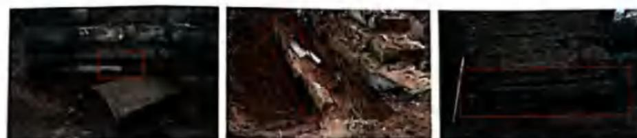
(A) 7号塔土衬底层砖的错位 (B) 残塔底层砖的反翘 (C) 行军塔条石及土衬的变形
