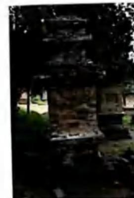
图 6-11 7号塔完整倾斜
