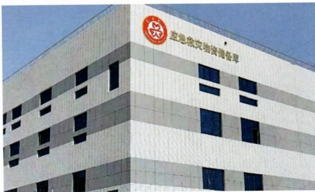
图5各级应急物资储备库悬挂标识示例
