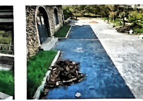
流域生态环境综合治理提升工程
