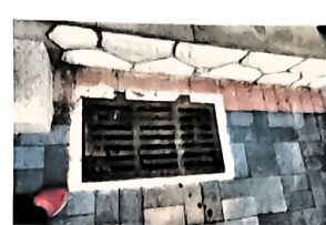
流域生态环境综合治理提升工程
