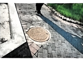
流域生态环境综合治理提升工程
