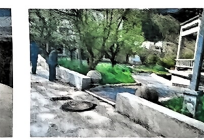
流域生态环境综合治理提升工程
