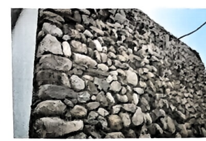
流域生态环境综合治理提升工程
