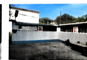
流域生态环境综合治理提升工程
