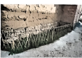
流域生态环境综合治理提升工程
