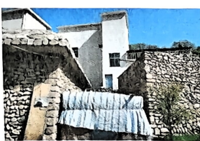
流域生态环境综合治理提升工程
