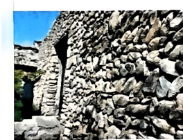
生态环境综合治理提升工程
