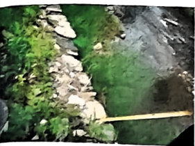
流域生态环境综合治理提升工程
