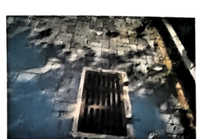
流域生态环境综合治理提升工程
