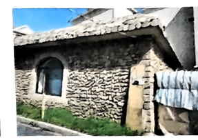
流域生态环境综合治理提升工程
