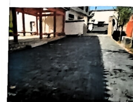
生态环境综合治理提升工程
