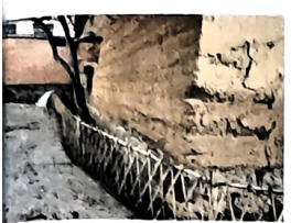
生态环境综合治理提升工程
