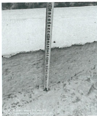
附件 3 (25cm 厚 C25 混凝土路面测量图片) 第一段
