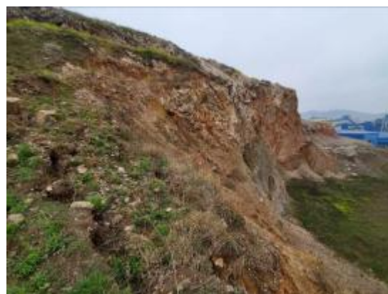
照片 3-4 边坡中段上方斜坡形态
