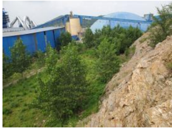
照片 3-6 边坡紧临厂区
