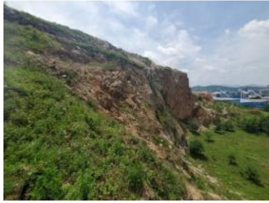
照片 3-30 边坡上部危岩体及裂缝
