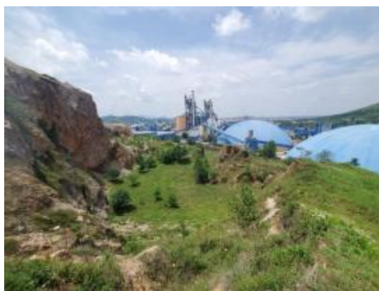
照片 2-8 厂区紧临矿区北侧
