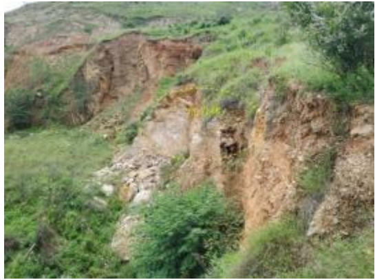
照片 3-28 边坡危岩体及崩积物
