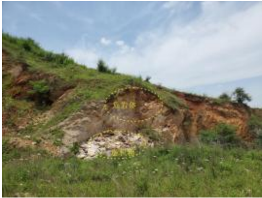
照片 3-27 边坡上部危岩体及崩积物
