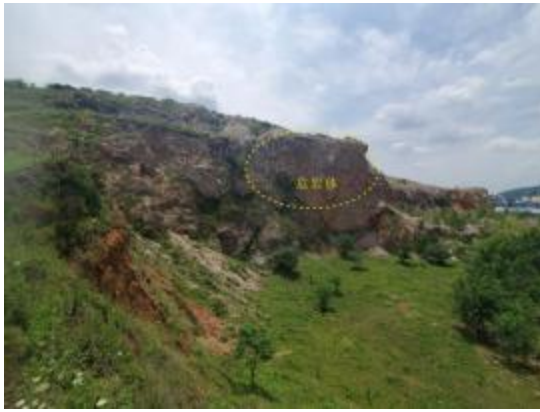
照片 3-29 边坡上部危岩体
