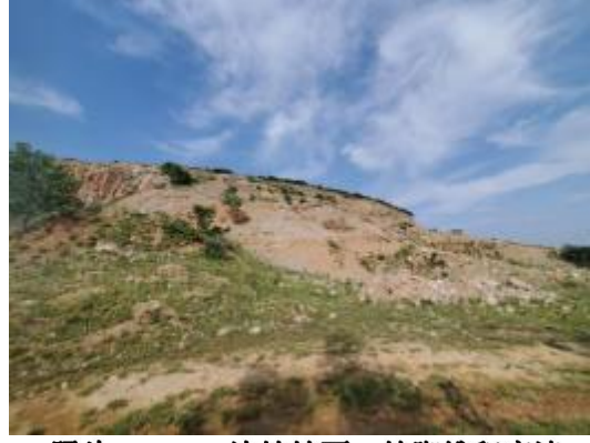
照片 3-10 边坡坡面、坡脚堆积废渣
