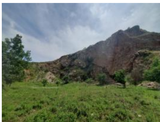
照片 3-3 边坡中段现状
