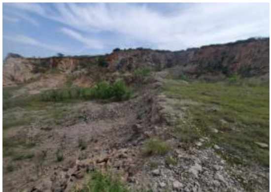
照片 3-16 边坡坡面、坡脚堆积废石、废渣
