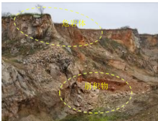
照片 3-36 边坡危岩体及崩积物
