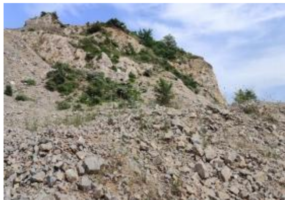
照片 2-2 边坡坡面堆积的废石、废渣
