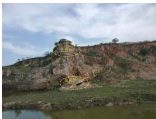
照片 3-35 崩塌全貌
