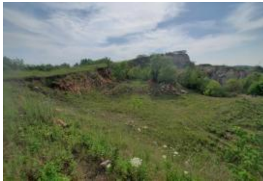
照片 3-20 采坑南部边坡上方斜坡形态
