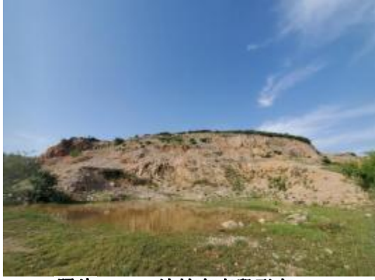
照片 3-9 边坡东南段形态
