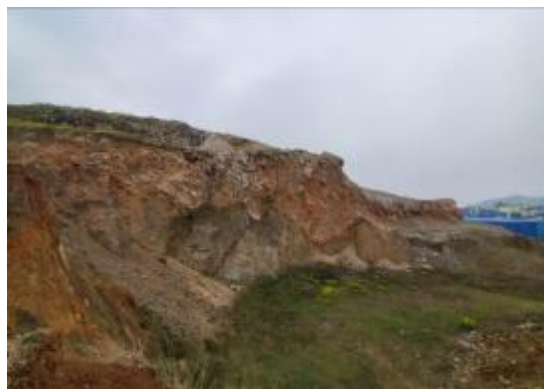
照片 3-2 边坡中段全貌
