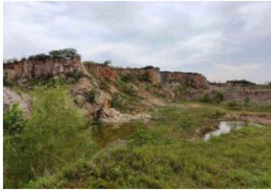
照片 3-18 采坑南部边坡全貌
