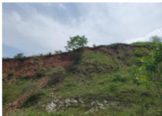
照片 3-1 边坡东段现状
