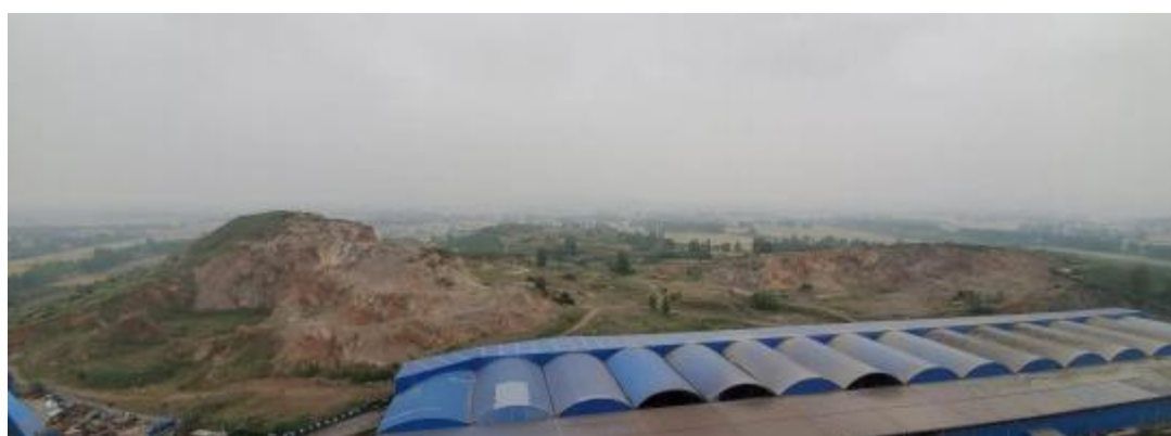
照片 8-1 洪虎山废弃矿区整体现状
