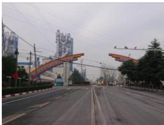
照片 2-7 驻马店市豫龙同力水泥有限公司厂区
