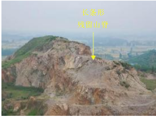
照片 3-5 边坡西段残留山脊
